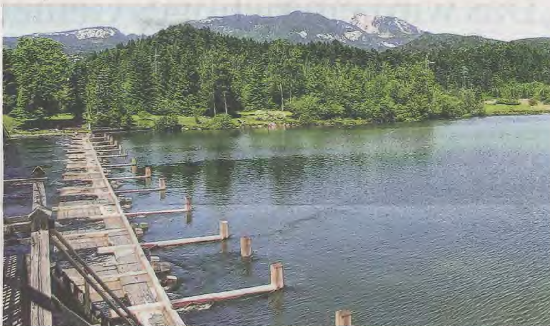
Historische Anlage: Bereits vor mehr als fünf Jahrhunderten wurde mit der Seeklause der Wasserstand geregelt. Foto: Öfb
