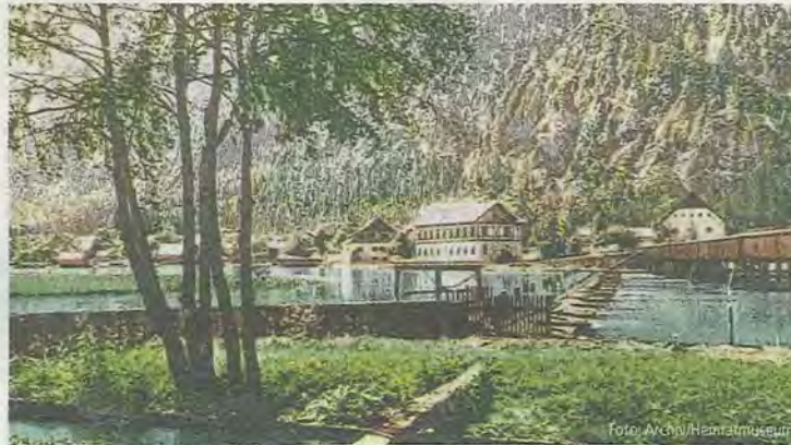
Historische Ansicht der mehr als 500 Jahre alten Seeklause Steeg: Experten wollen das Bauwerk erhalten und an moderne Anforderungen anpassen.
